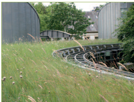
Der Natur nach oben verhelfen: Grüne Dächer bieten Gräsern, Moosen oder Kräutern Platz zur Entfaltung. Das lockt zahlreiche kleine Lebewesen an. Regenwasser verdunstet hier nur langsam - das sorgt für Kühlung. © Deutsche Bundesstiftung Umwelt
