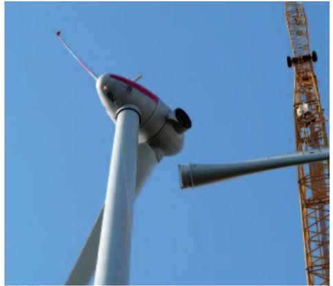
Bild 1; Windkraftanlage, Bildbeschreibung: Rotorblattmontage einer modernen Windkraftanlage, [greenvalue.de](http://greenvalue.de)
